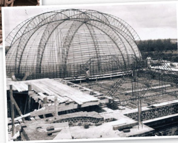
พระที่นั่งอนันตสมาคมขณะก่อสร้าง เห็นการผูกเหล็กเส้นเพื่อหล่อคอนกรีต สำหรับใช้เป็นโครงสร้างส่วนต่างๆ ของอาคาร Ananta Samakhom Throne Hall: Steel bars were bundled to form the concrete used in the structure of this majestic building.
