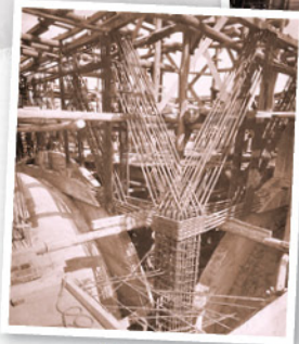
พระที่นั่งอนันตสมาคมขณะก่อสร้าง เห็นการผูกเหล็กเส้นเพื่อหล่อคอนกรีต สำหรับใช้เป็นโครงสร้างส่วนต่างๆ ของอาคาร Ananta Samakhom Throne Hall: Steel bars were bundled to form the concrete used in the structure of this majestic building.
