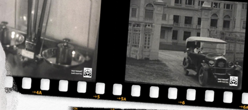
รถยนต์ขับเคลื่อนออกจากประตูหน้ากระทรวงฯ ซึ่งปัจจุบันเป็นจุดขึ้นลงสถานีรถไฟฟ้าสนามไชย A car passing through the gate in front of the Ministry. Currently, it is the entrance of the Sanam Chai MRT Station.
